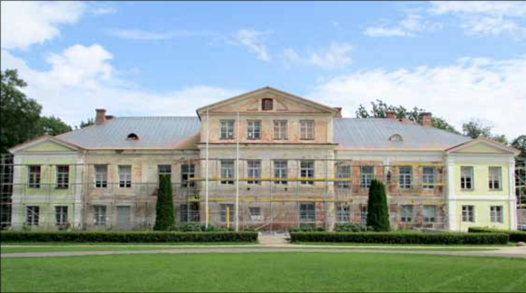
Hoone välisfassaad saab sel suvel nüüdisaegse kollase värvitooni. Lisaks korrastatakse ka välisaknad ja uuendatakse vihmaveetorude süsteem ning katus. Endist rõdu ei ole plaanis taastada, kuid see märgitakse ära piirjoontega, et saada aimu algsest ehitusest. FOTO: JAANUS KASK
