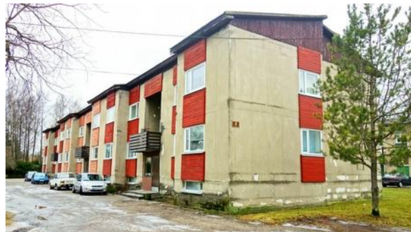
Joonis 2.1.12. Põllu tn 3
