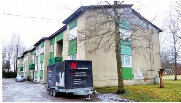
Joonis 2.1.14. Põllu tn 5
