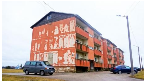
Joonis 2.1.16. Põllu tn 8
