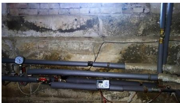
Joonis 2.1.20. Põllu tn 5 soojussõlm
