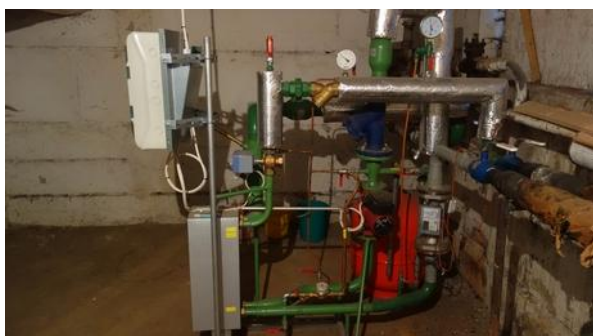
Joonis 2.1.19. Põllu tn 4 soojussõlm
