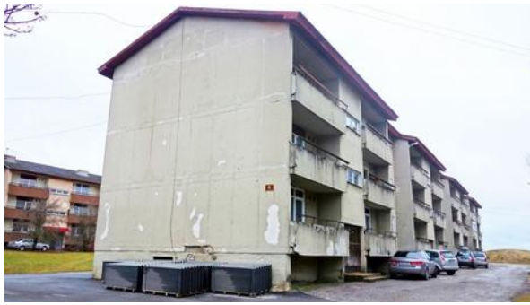
Joonis 2.1.13. Põllu tn 4
