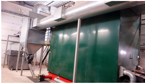
Joonis 3.1.2. Põhikatel Wetorex 1500MG
