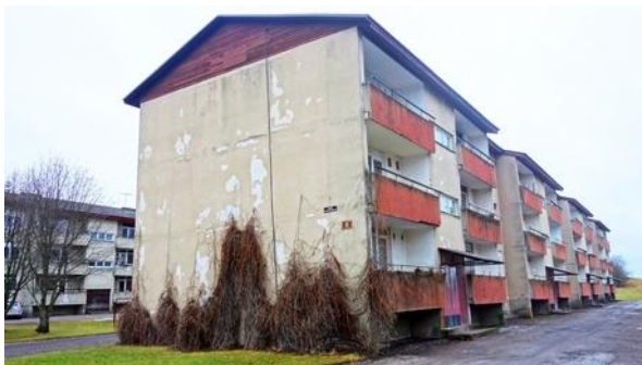
Joonis 2.1.11. Põllu tn 2
