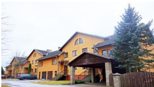
Joonis 2.1.17. Põllu tn 10
