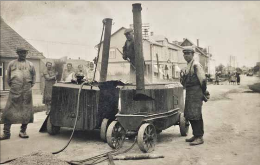
Teetööd Türil Viljandi tänaval. Käsil on parasjagu asfaldi panek. Ega muud keerulist töö juures polnudki, kui katel tuli puudega kuumaks kütta, kuum pigi teele valada, seejärel killustik peale ja ootevalmis naisterahvad ajasid selle luudadega ühtlaselt laiali. Teeäärsed pärnapuud on veel nii väikesed, et ei paista õieti väljagi. FOTO RENE VILJATI KOGUST
